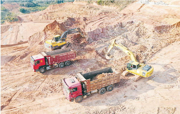
漳武高速公路南靖段建设项目A1标路基施工现场 漳州通平漳武高速公路有限公司 供图
