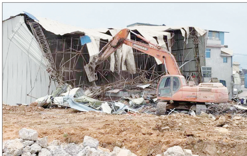
4月20日上午,漳州高新区依法拆除圆山大道三标段道路边三处民房屋顶违规搭盖及铁皮搭盖内套建改建存在安全隐患的建筑物,拆除面积约1220平方米。
