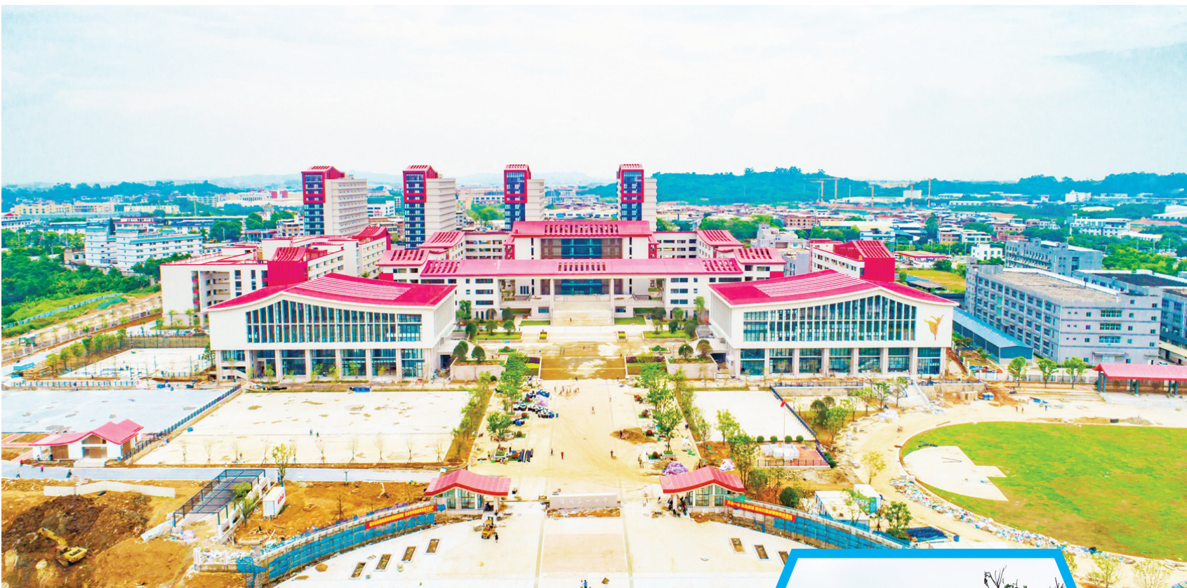
▲漳州一中高中部项目建设航拍全景图
