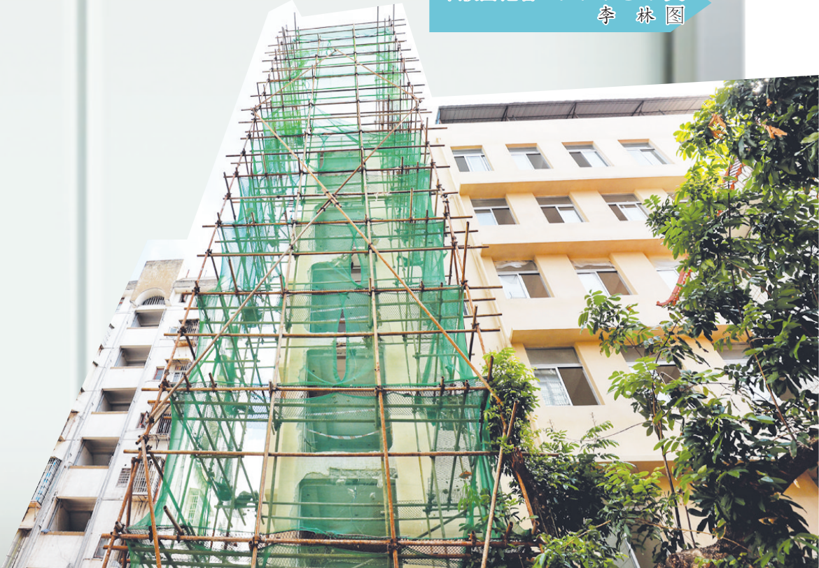
人民新村老旧小区房在建电梯
