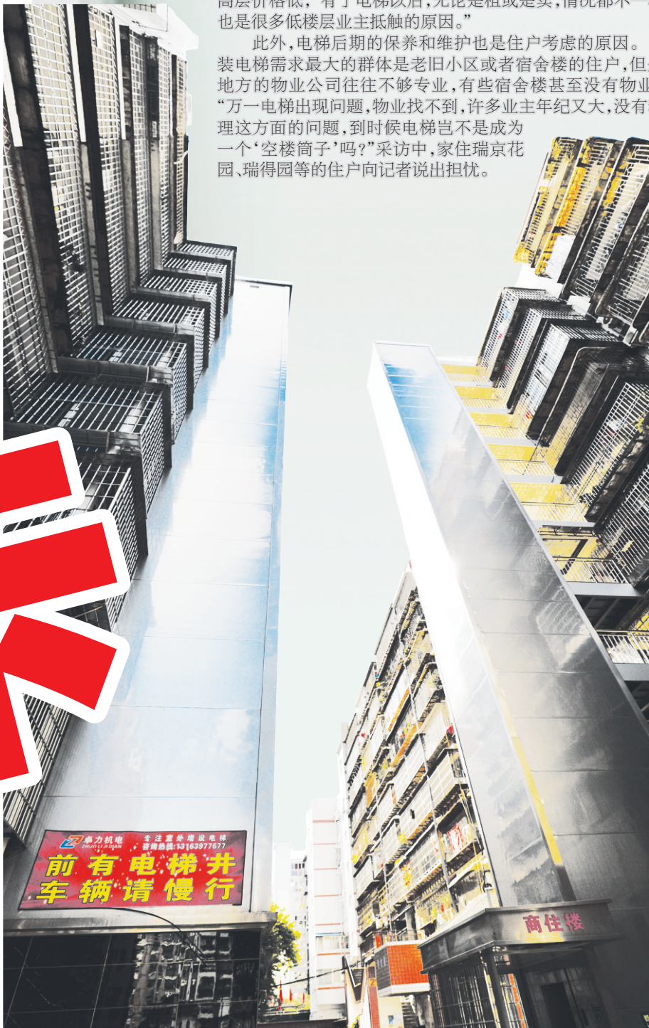
人民新村老旧小区房已建成电梯
