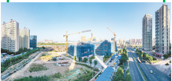
建设中的市实小龙文校区(2020年11月) 李杰 摄
