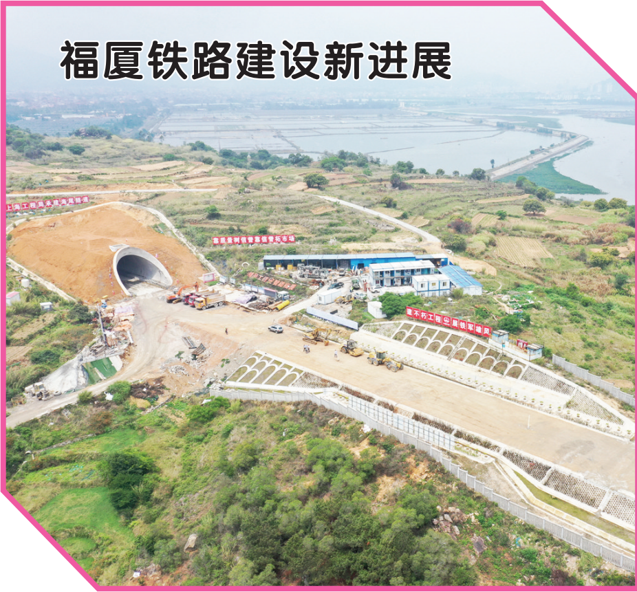
4月29日拍摄的 中铁上海工程局承建 的新建福厦铁路海尾 隧道进口(无人机照 片)。
