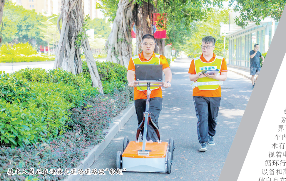
在人民广场地下通道里,技术人员正在操作便携式双频地质雷达检测车进行道路“体检”。
