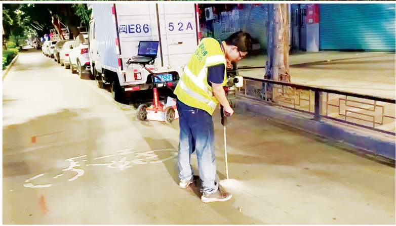
►技术人员在疑似病害的路面进行钻孔,以进一步探查具体情况。
