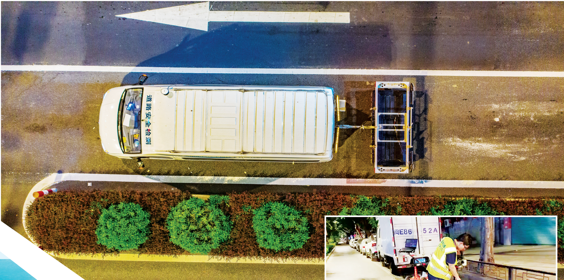
▲车载式探地雷达正在江滨路上检测地下空洞等道路“隐疾”
