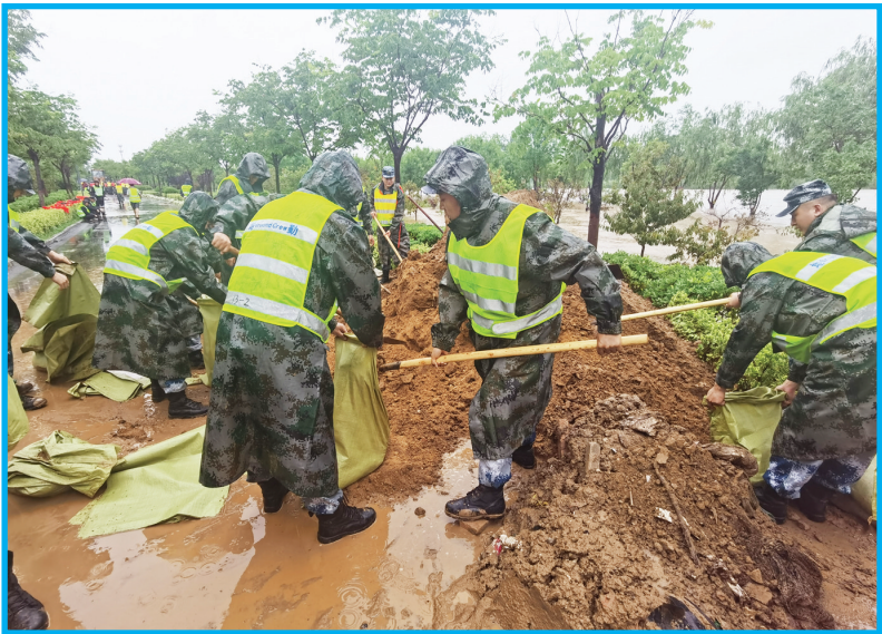
7月21日,驻扎在郑州的中部战区空军某部官兵在贾鲁河中段装填沙袋加固堤坝(手机拍摄)。
