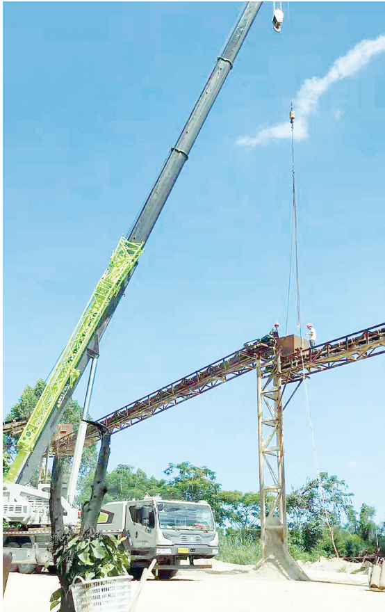
非法洗砂场输送带设备正在拆除中
