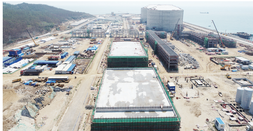
漳州LNG加快建设 钟路珂 供图
