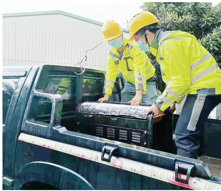
运送油机前往断电站点发电
