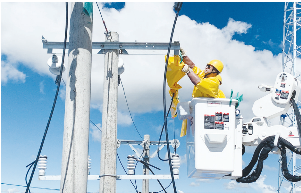
柯毅群在那曲市开展业务帮扶,进行带电作业实训。
