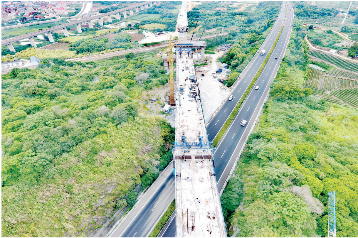
福厦高铁漳州九龙江特大桥跨沈海高速连续梁顺利合龙施工现场
