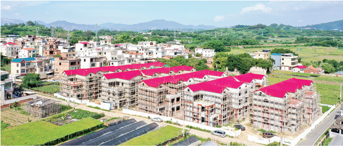
建设中的郭坑镇洛滨新村
