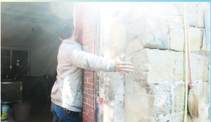
平和延安楼墙厚1.5米以上
