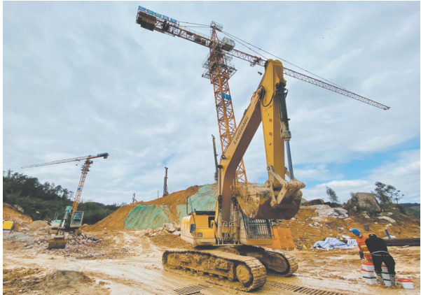
▲曜阳国际康养中心项目位于马洋溪生态旅游区十里村,旨在打造华东地区首屈一指的城市精致休闲微度假文旅标杆项目。一期A01医院地块、A18商业地块已于2021年12月开工建设,目前正在进行基础施工,预计今年完成主体结构封顶。
