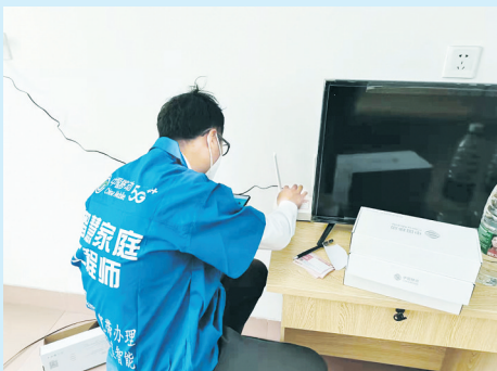
在新增隔离点里,漳州移动装维人员正在安装调试宽带。
