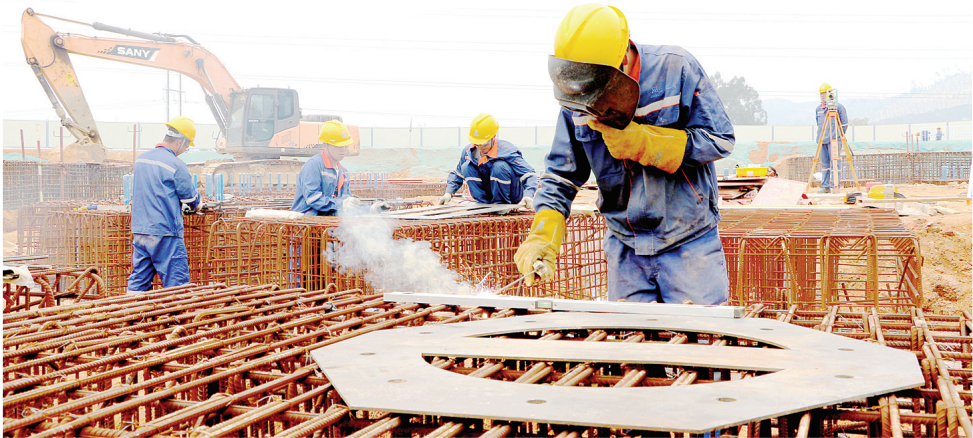
华龙科技文化园施工现场
