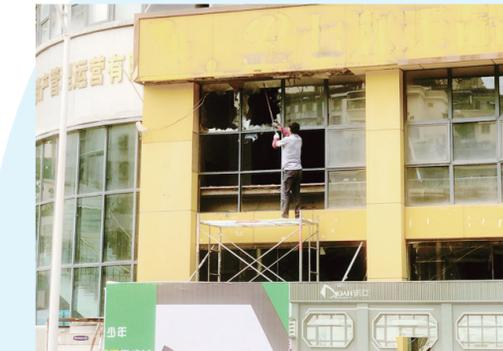
近日,记者在市区天下广场小区附近看到,工人在装修店面、拆除玻璃墙时忽视安全保障,未佩戴安全帽,未设置安全护栏,存在一定安全隐患。记者呼吁工人应提高安全意识,安全施工。有关施工方也应加强对工人的安全教育培训,尽可能排除施工安全隐患。
