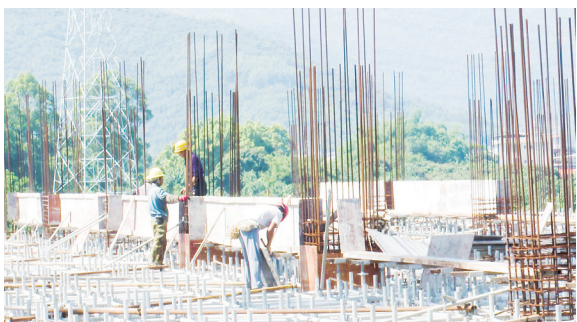
南靖闽台精密机械产业园标准厂房一期工程施工现场
