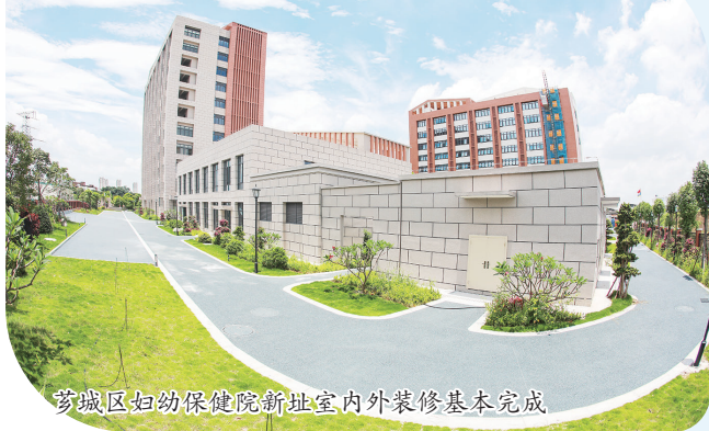
芗城区妇幼保健院新址室内外装修基本完成
