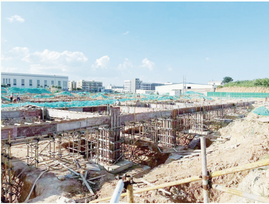
奇力护理项目已完成桩基工程施工作业
