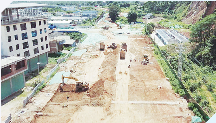
平和县东环路一期(续建)工程项目施工现场
