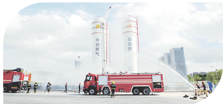
古雷开发区举行2022年LNG储配站燃气泄漏应急演练
