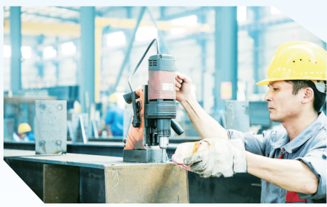
博槐钢结构工人正在加工钢构件
