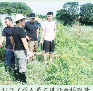
征迁工作人员正在进行放样测量
