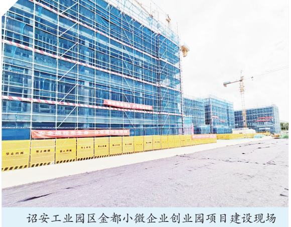
诏安工业园区金都小微企业创业园项目建设现场
