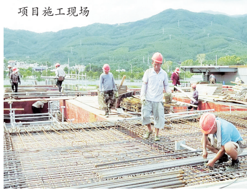
项目施工现场
