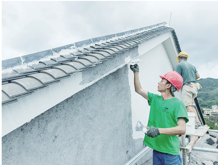
工人们稳步推进通美云水谣商业街项目施工 魏树煌 摄
