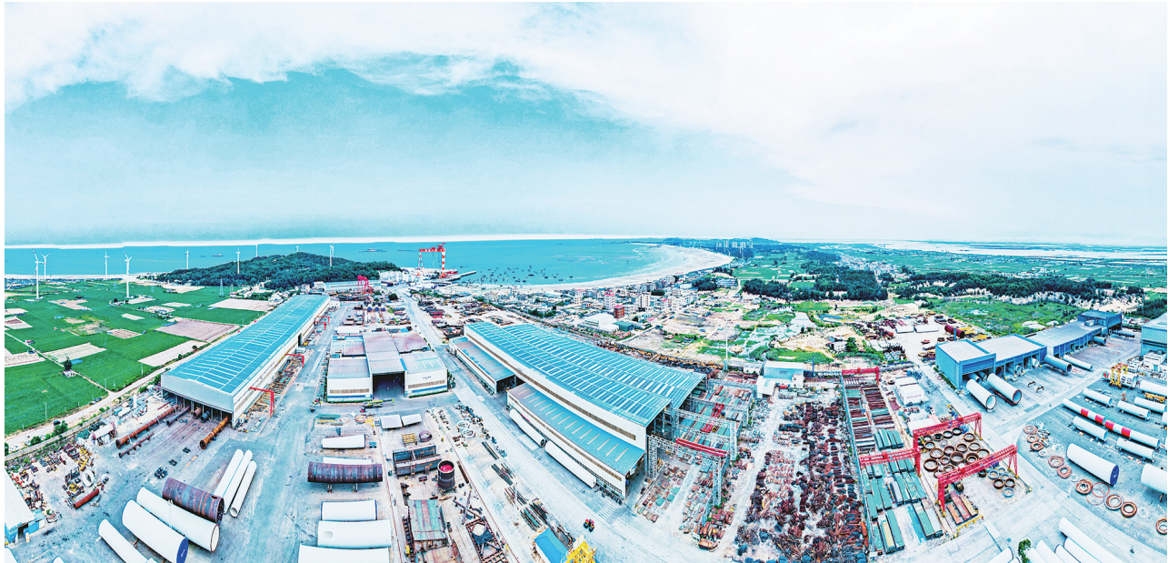
位于六鳌半岛的福建福船一帆新能源装备制造有限公司(资料图片)
