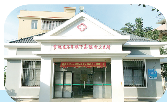
芗城区公办村卫生所全部采用新建模式,做到建筑面积、外观设计、设施配置、牌匾制作安装“四统一”。
