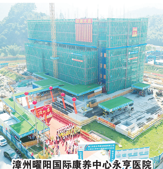
漳州曜阳国际康养中心永亨医院 主体封顶
