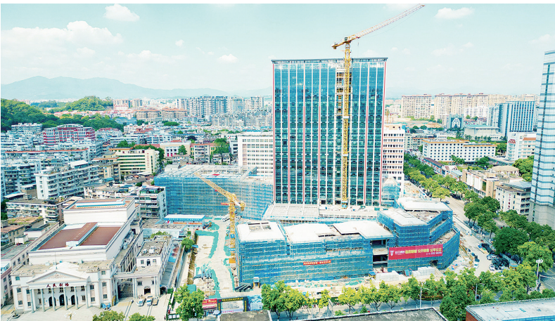
梦江酒店主楼外立面装饰装修基本完成 本报记者 严洁 摄
