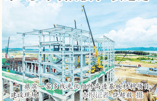
旗滨一窑多线光伏组件高透基板材料项目建设现场。本报记者 饶超毅 摄
