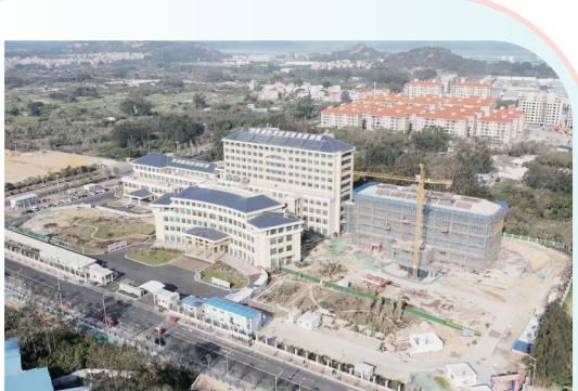
县中医院二期、三期工程建设现场
