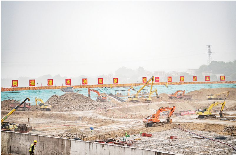
九龙江西溪水闸除险加固工程项目现场
