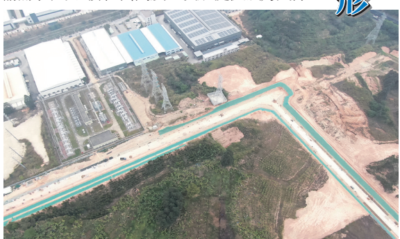
三十五路市政道路工程项目航拍
