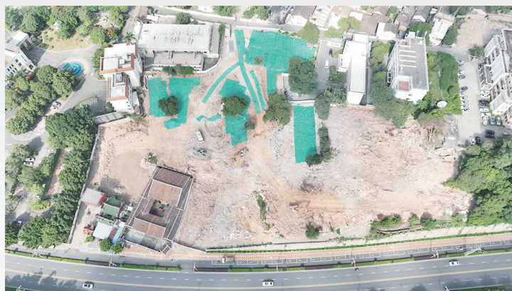
▲长泰历史街区(中山南路-后庵片区)一期项目航拍图
