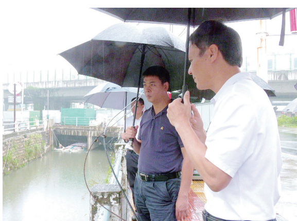
6月15日,云霄县县长沈顺来到向北溪五板桥段调研,现场了解中心城区污水提质增效工程进度。
