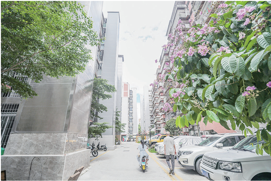
改造并加装电梯后的人民新村小区
