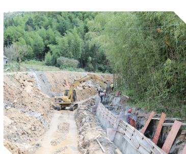
在奎洋镇仙岭村小流域支流生态修复(河道清淤)及生态廊道建设工程现场,工人们忙着安装挡墙模板,机械和人工配合进行挡墙浇筑。
