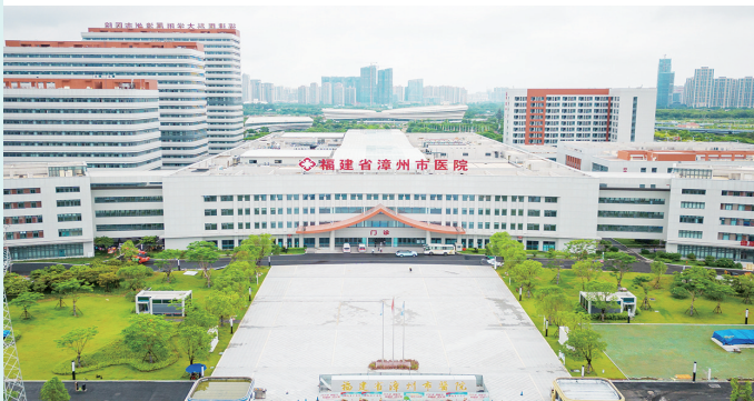
漳州市医院总部院区航拍 本报记者 严洁 摄
