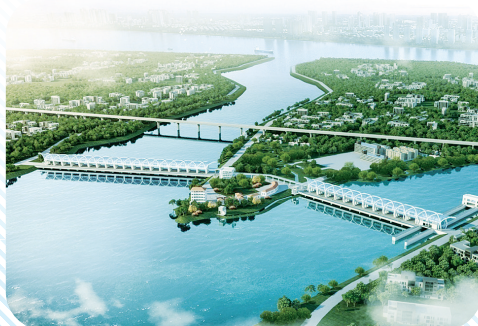
福建省九龙江北溪水闸改建工程
