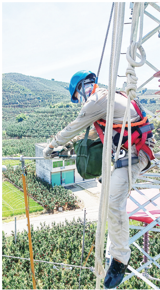
在110kV南格线#27塔上,赵凌杰给导线缠绕铝包带。
