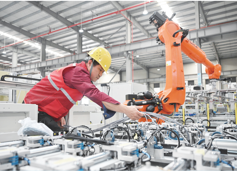
2月19日,宁德思客琦智能装备有限公司工作人员在安装调试机器人自动化设备。
