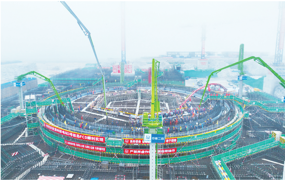
2月22日,中核集团漳州核电二期工程3号机组浇灌核岛第一罐混凝土,标志二期工程建设序幕全面拉开。漳州核电 供图
