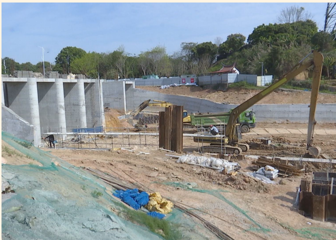
大水港排涝闸除险加固工程项目施工现场
