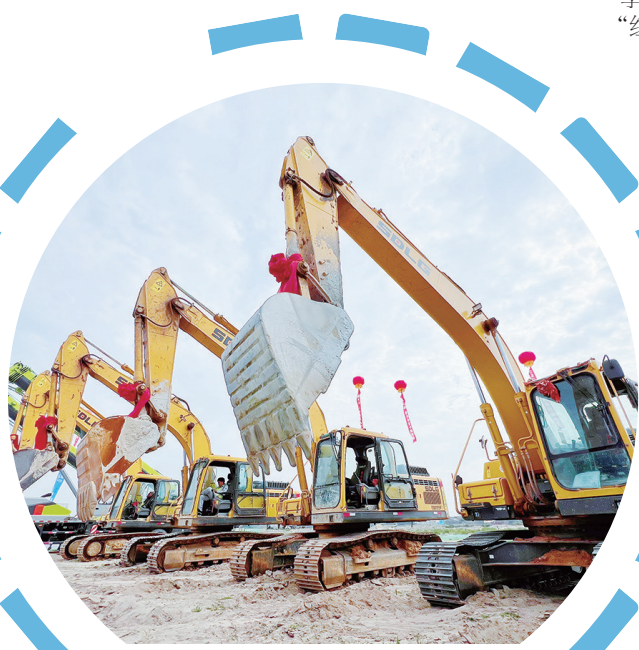
▲中国石化南化苯胺-橡胶助剂产业链项目开工现场 游斐洲 摄
