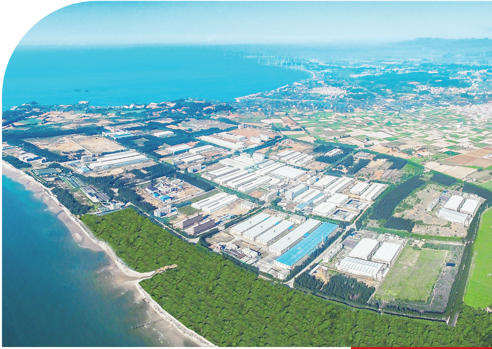
赤湖工业园区航拍图 赤湖工业园区 供图
