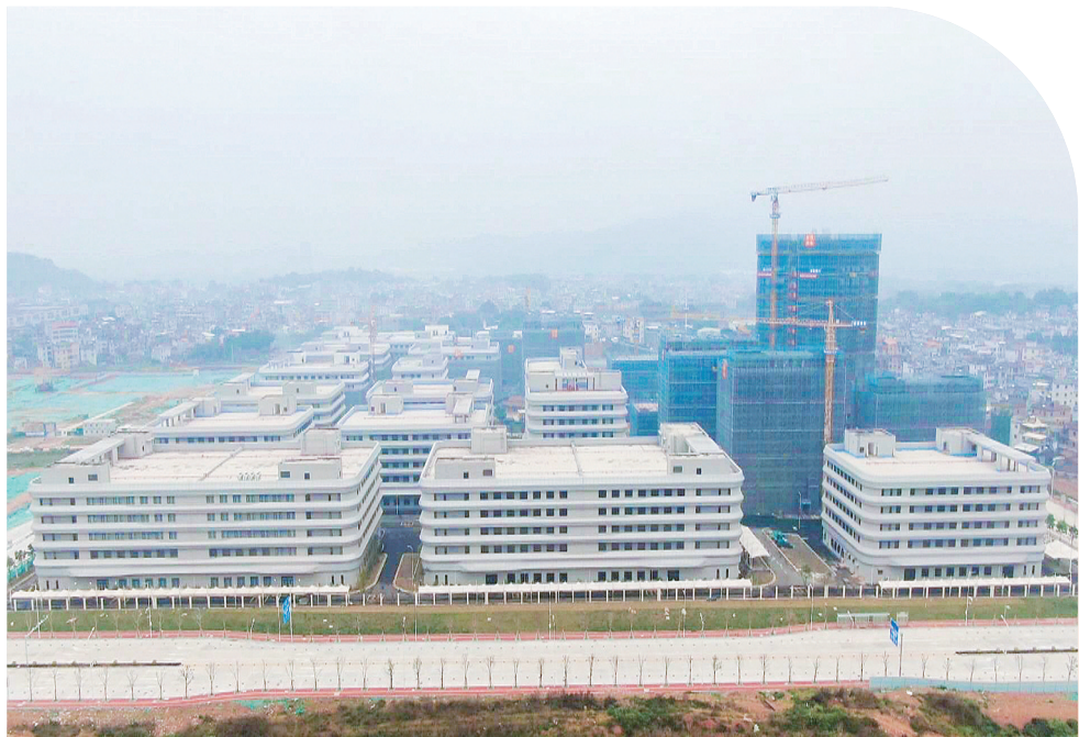
建设中的科技产业园
